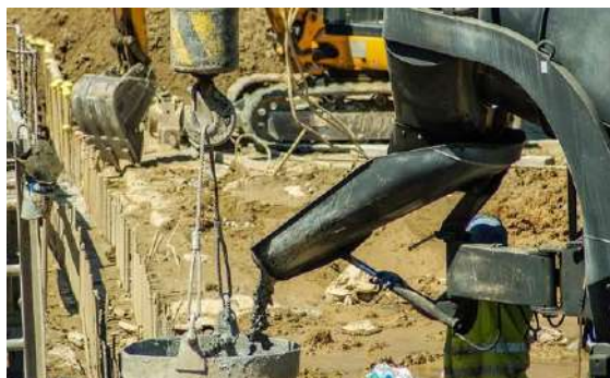
Figura 85 - Betonagem (exemplo)
