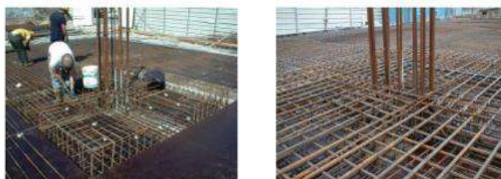
Figura 84 - Colocação de armaduras (exemplos)
